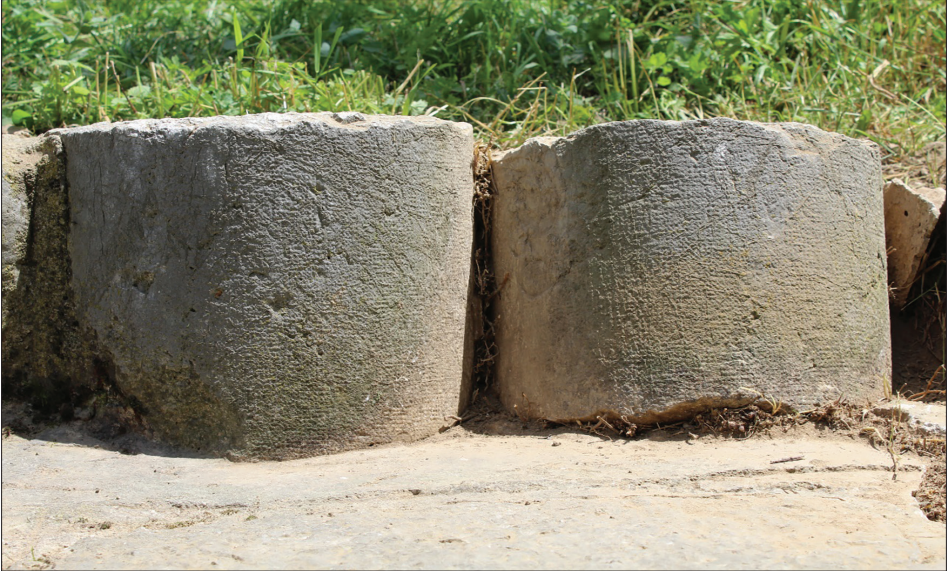
Sl. 4. Ulomci stubova kružne osnove s prikazom tretmana površine kamena zubačom
